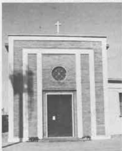
La cappella presso la Montecatini, dove don Ponzetto trafugava gli arredi sottratti alla cappella del collegio.
