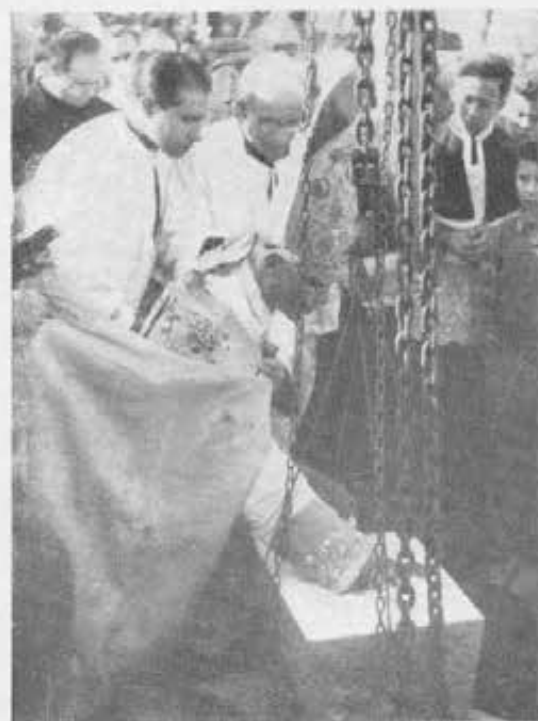
A VENDAS NOVAS si sta costruendo la prima chiesa del PORTOGALLO dedicata a San Domenico Savio. Qui l'Arcivescovo di Evora compie la cerimonia della posa della prima pietra.
