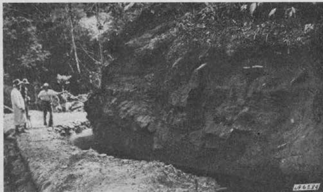
Sangradouro - Un tratto di canale aperto a dinamite.
