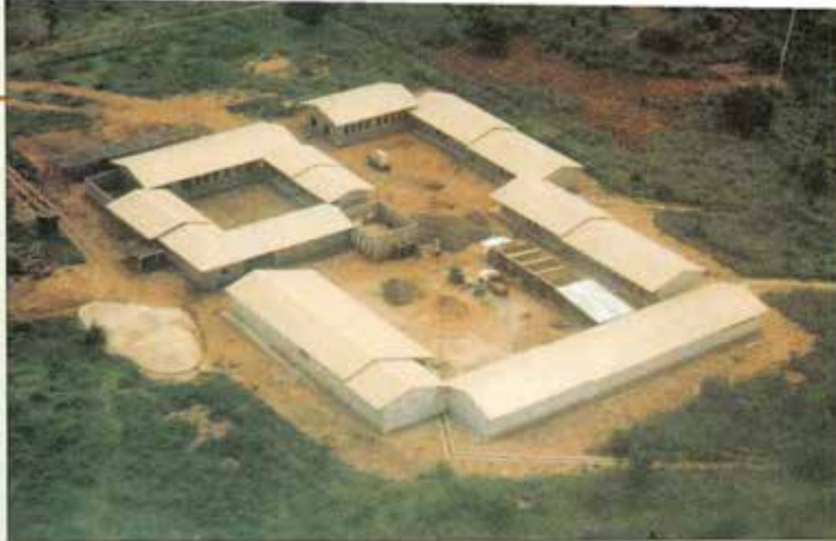
Kasenga. Centro di formazione Madre Morano, inaugurato il 18 settembre 1998.
