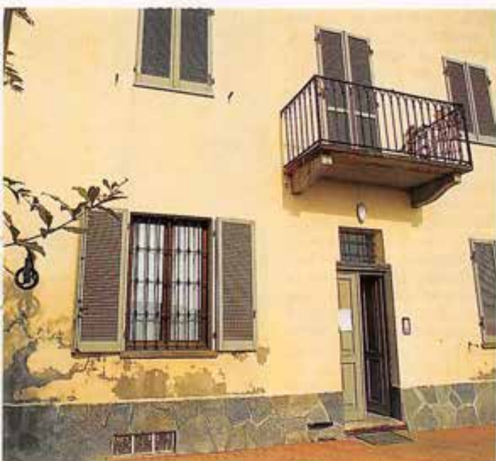
La scuola di Montaldo (To) (Foto Pera).
