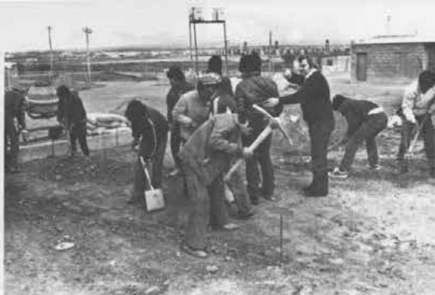
Padre Renzo dirige i lavori per la costruenda «Vivienda».
