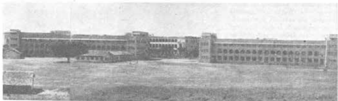
INDIA - BOMBAY - La grande «Scuola Don Bosco». Al centro, lo spazio per la costruzione della chiesa.
