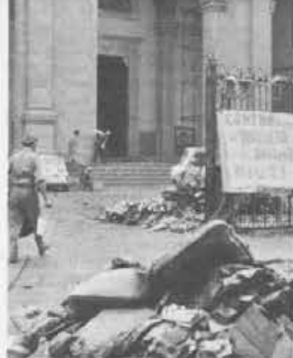
E dopo l'alluvione, la ricostruzione.
