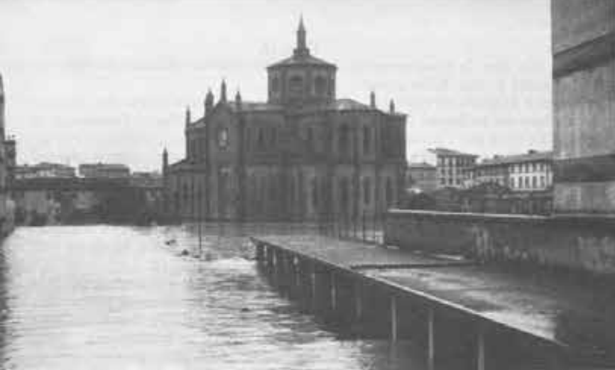
Venezia? No: Firenze sotto l'alluvione del 4.11.1966. La casa salesiana subì gravi danni.
