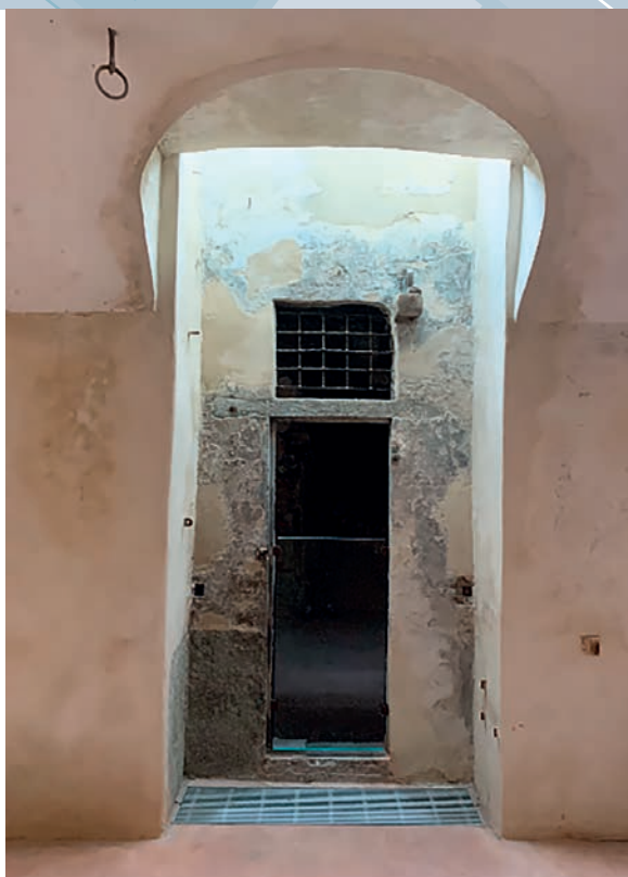
L'accesso al pozzo.
