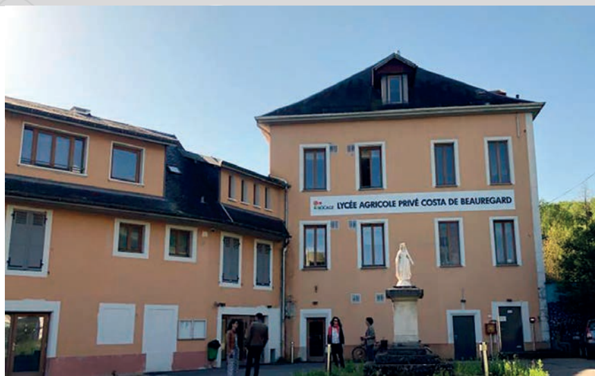
Sopra: L'entrata del Bocage oggi.
