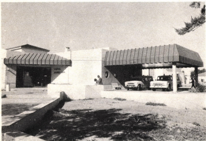
NUOVO OSPEDALE DI VIEDMA : uno degli ingressi. Naturalmente è stato intitolato a Artemide Zatti, parente di tutti i poveri.
