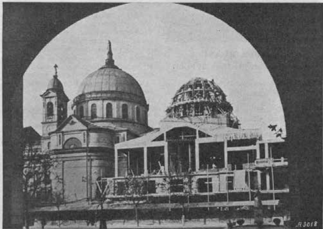
Il progresso dei lavori nel mese di ottobre.
