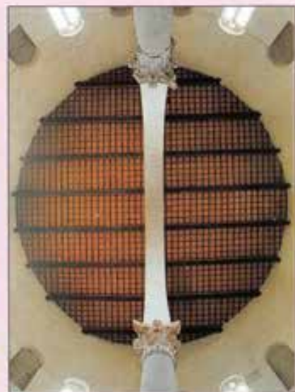
La veduta del tamburo centrale con travatura ad elementi paralleli.
