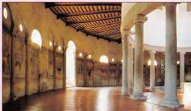
Parte del grande deambulatorio che forma la basilica, con la copertura a travi radiali.
