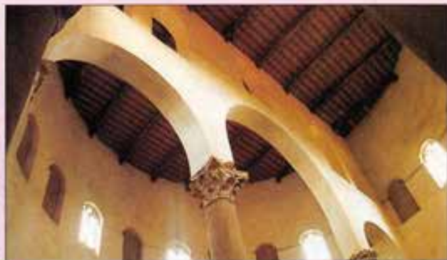
Le tre arcate centrali sulle quali poggiano le travi del tetto.
