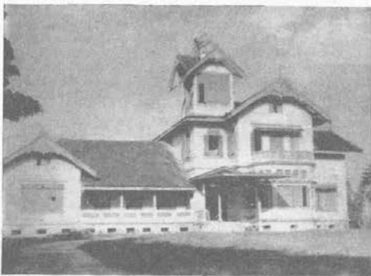
SIAM - Bang Kok - La nuova Casa che ospita i "ragazzi di Don Bosco".
