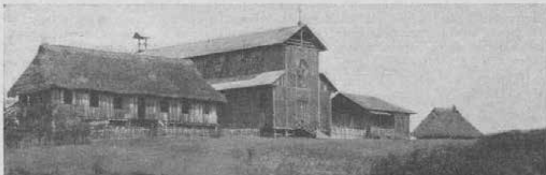
Macao (Equatore). - La chiesa e gli edifici centrali della Missione, prima dell'incendio
