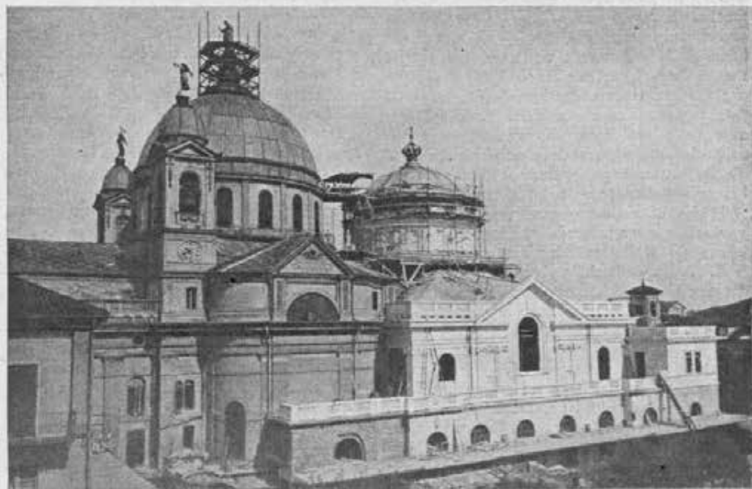
Torino. - Ampliamento della Basilica di Maria Ausiliatrice. Lo stato dei lavori al 1° luglio
