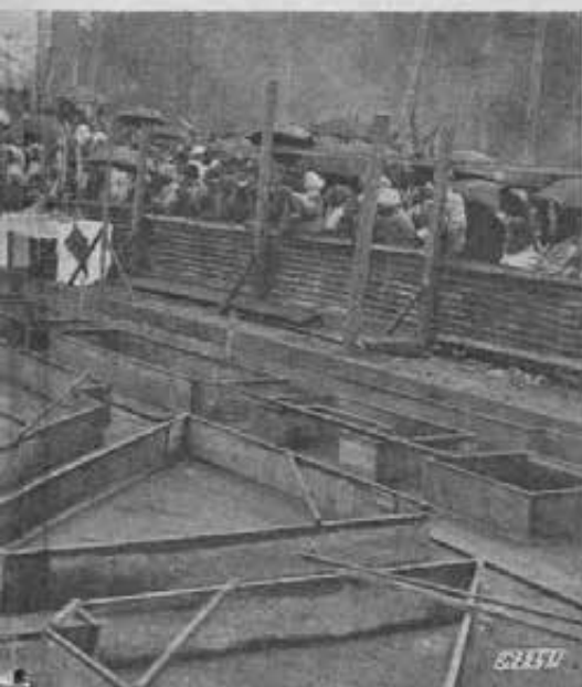
Il vescovo benedice le fondamenta della chiesa di quella distrutta dal fuoco.
