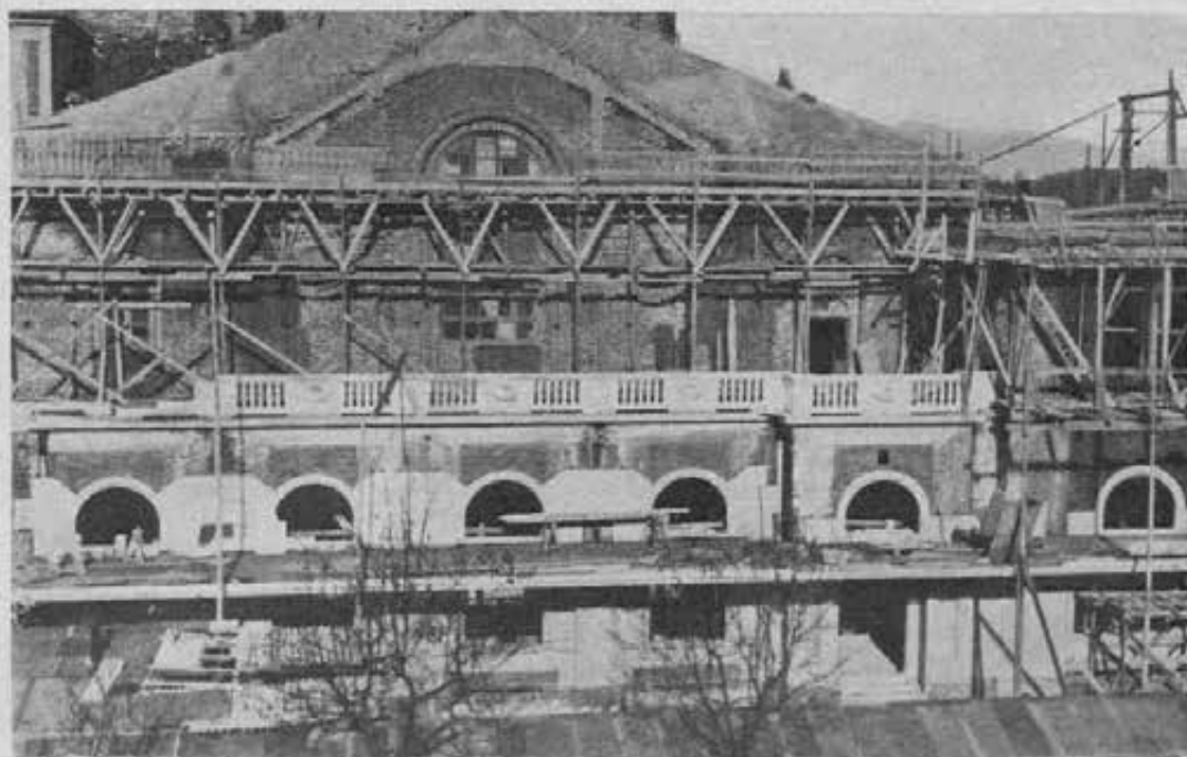
I lavori al santuario di Maria Ausiliatrice. Sulle pareti esterne comincia a biancheggiare il travertino.
