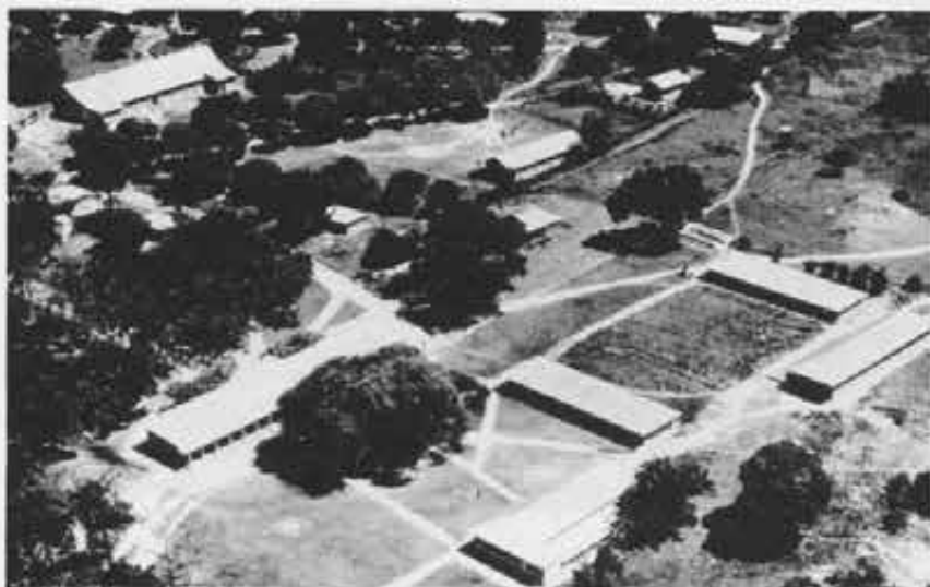
Veduta aerea della Secondary School di Siakago
