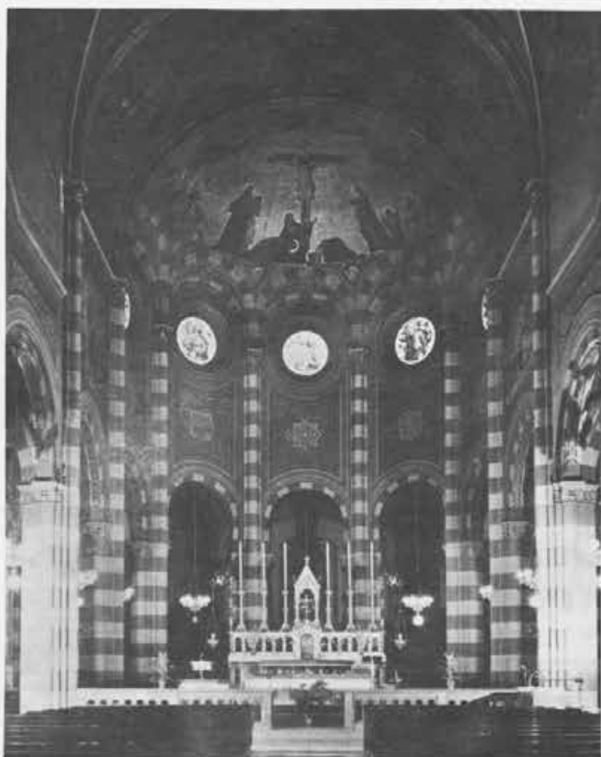
L'abside della stessa chiesa.
