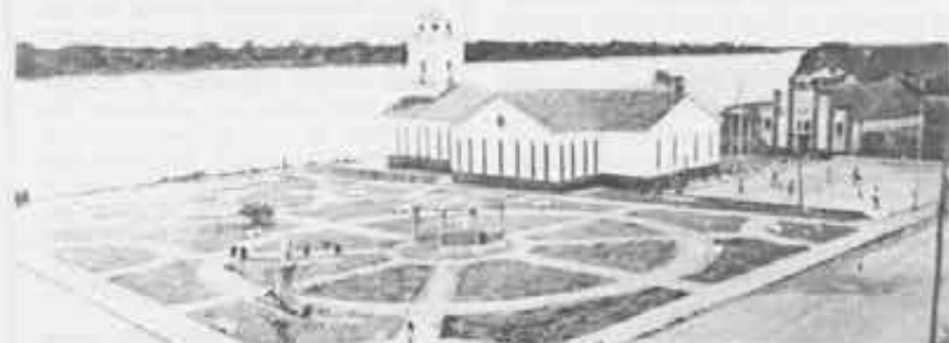
Humaità: la cattedrale di mons. D'Aversa, affacciata sul rio Madeira (che in quel punto misura un chilometro di larghezza).
