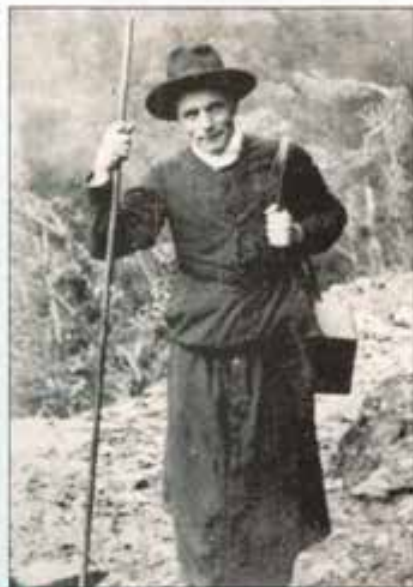
Don Albino ai tempi della costruzione della strada transandina.
