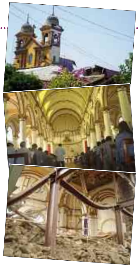
Sopra, la basilica di Maria Ausiliatrice di Linares, dopo il terremoto. Si sono salvate solo la facciata e le torri campanarie, mentre l'interno è andato distrutto. Al centro, l'interno e sotto come è stato ridotto dal terremoto.
