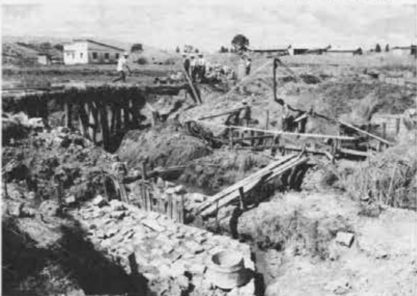
Costruzione del primo ponte finanziato dalla Misereor tedesca
