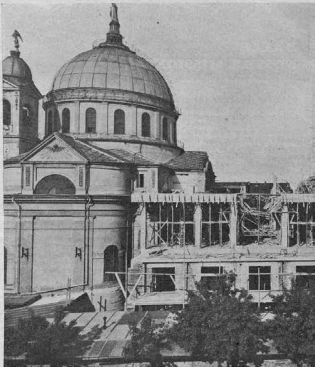
Torino: Santuario di Maria Ausiliatrice. - Stato generale dei lavori in settembre. - In
