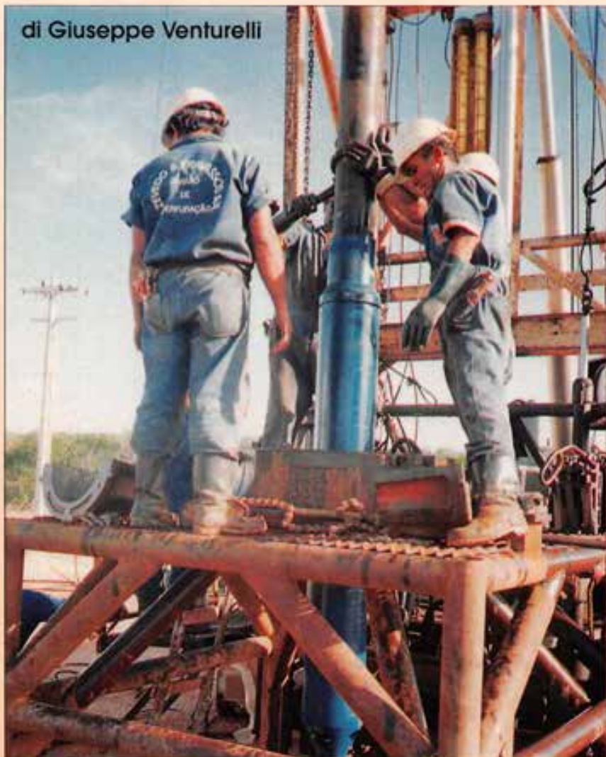
Areia Branca (Brasile). Si sistema la pompa. Viene applicata al motore e scenderà fino a 350 metri di profondità.
