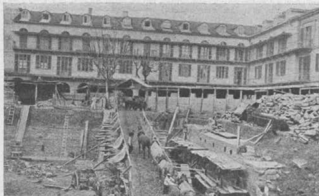
Torino. - Fervono i lavori per l'ampliamento della basilica di Maria Ausiliatrice.
