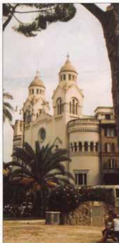
La chiesa valdese di piazza Cavour.
