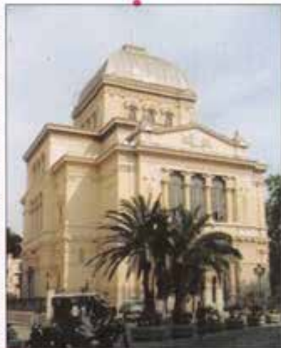
La sinagoga ebraica sul Lungotevere.
