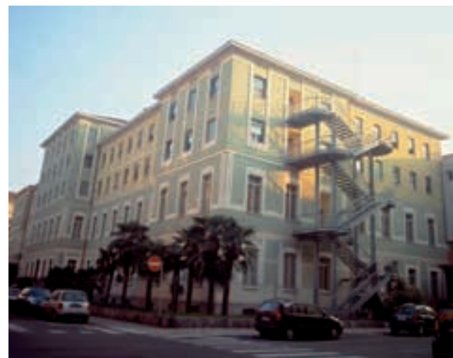
La storica sede della Crocetta (Torino). In alto e a pagina seguente: La sede dell'UPS a Roma.
