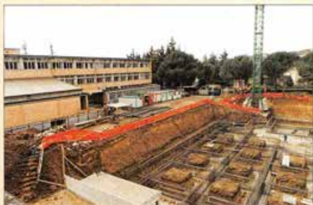
I lavori per le fondazioni della nuova Biblioteca. Sullo sfondo il palazzo delle aule.
