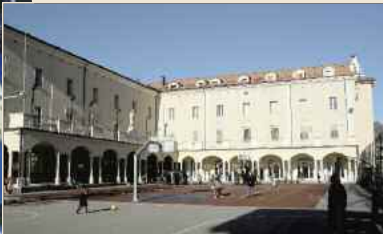
Sopra: una panoramica dell'opera salesiana di Schio.
