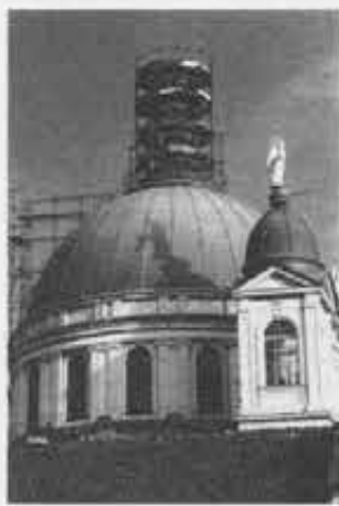
Nella foto: I lavori di indoratura sulla cupola di Maria Ausiliatrice a Torino
