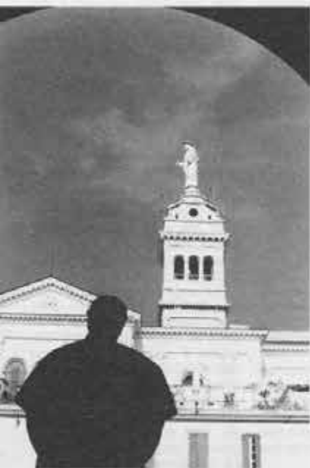
Una rara foto della Basilica in costruzione e alcune immagini attuali
