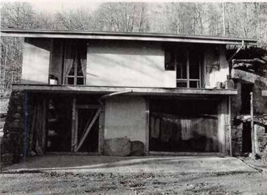
Alice Superiore (Torino). Qui don Gianfranco sta iniziando una seconda comunità in un edificio da ristrutturare.
