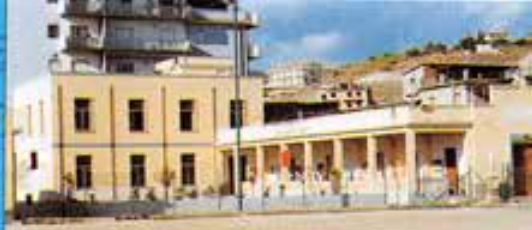
Veduta dell'istituto costruito nel 1949-50 da don Luigi Alessi. Fu sede della scuola media dal 1950 al 1964. Oggi è l'edificio dell'oratorio.
