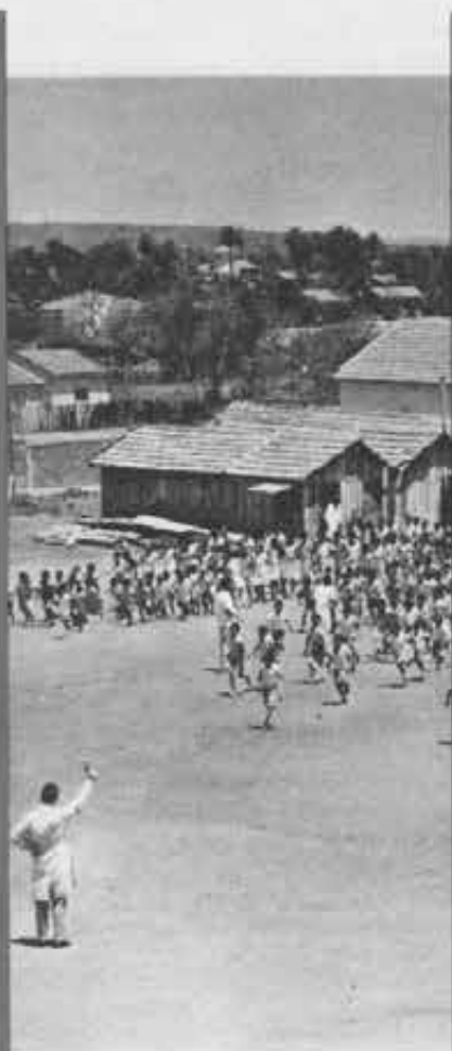
Veduta parziale della «Cidade Dom Bosco» con le sue costruzioni provvisorie
