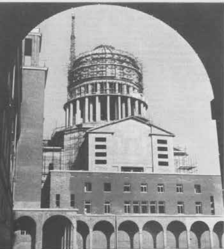
COLLE DON BOSCO Una inquadratura dell'abside del Tempio, visto dal cortile dell'Istituto. Nell'interno fervono i lavori per l'allestimento della chiesa inferiore
