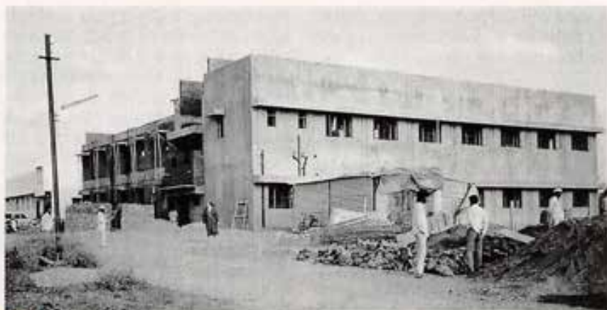
Ahmednagar. L'opera in costruzione.
