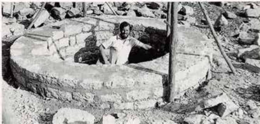
In Etiopia il problema acqua è drammatico. Cesare Bullo intende costruire nuove dighe e un centinaio di nuovi pozzi.
