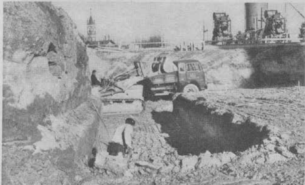
Colle Don Bosco (Asti) - Fervono i lavori di sterro per la costruzione del nuovo Tempio. Nello sfondo il piccolo Santuario di Maria Ausiliatrice dinanzi alla casetta natale di Don Bosco.
