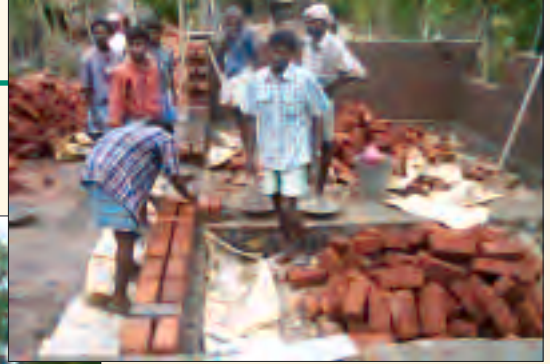
Operai al lavoro per il progetto/casette.
