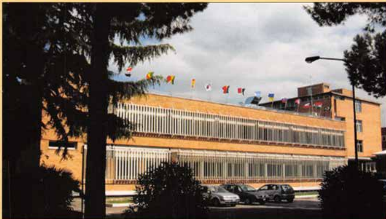
FSC veduta esterna a Nord.
