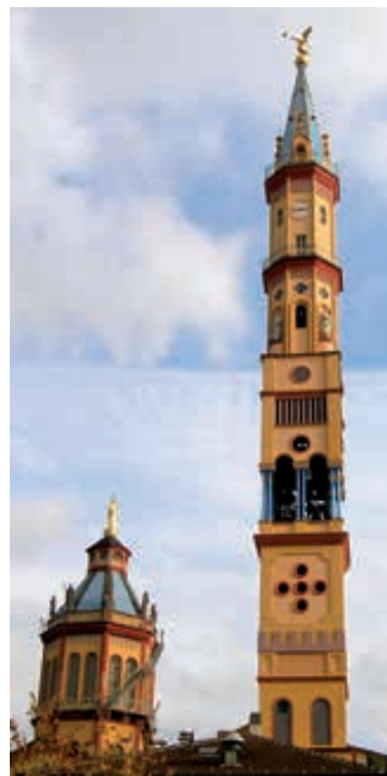
Chiesa e campanile di Santa Zita, opere del genio architettonico e multiforme del Beato Francesco Faà di Bruno.
