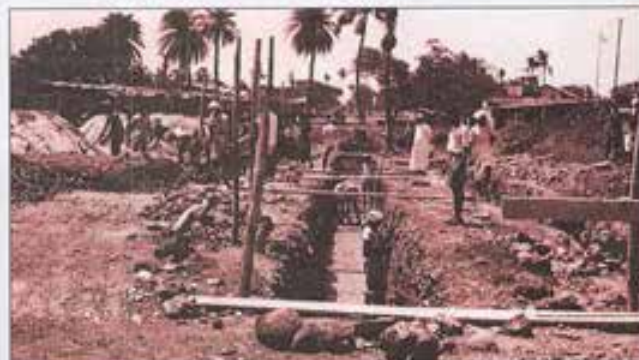
Si scavano le fondamenta della grande opera dopo la bonifica...
