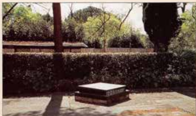
Lucernario nel cortile, che dà luce allo scavo sottostante.
